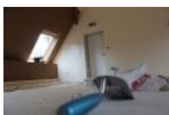
_ Dachausbau im VBS 2012
