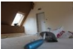
_Dachausbau im VBS 2012
